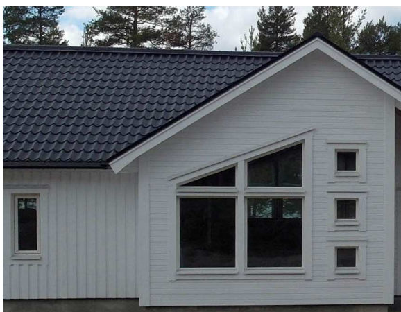
Kombination av liggande panel och stående lockpanel.
