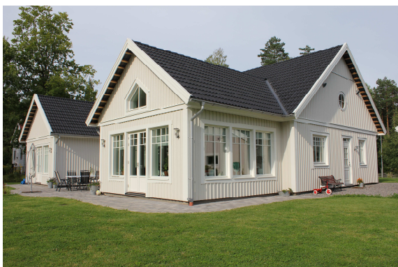
Lockläktpanel med ribbpanel.
